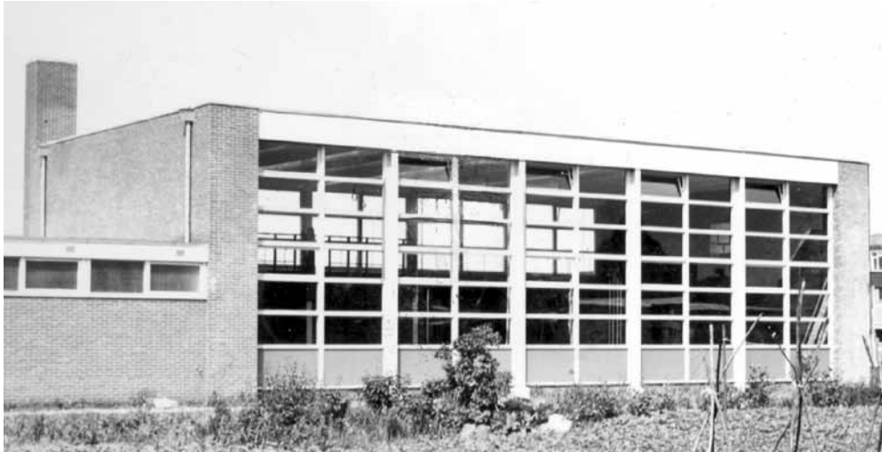
Gymnastiekzaal aan de Multatulistraat behorende bij de voormalige Scheepstraschool, later De Schakel (ca. 1970).
