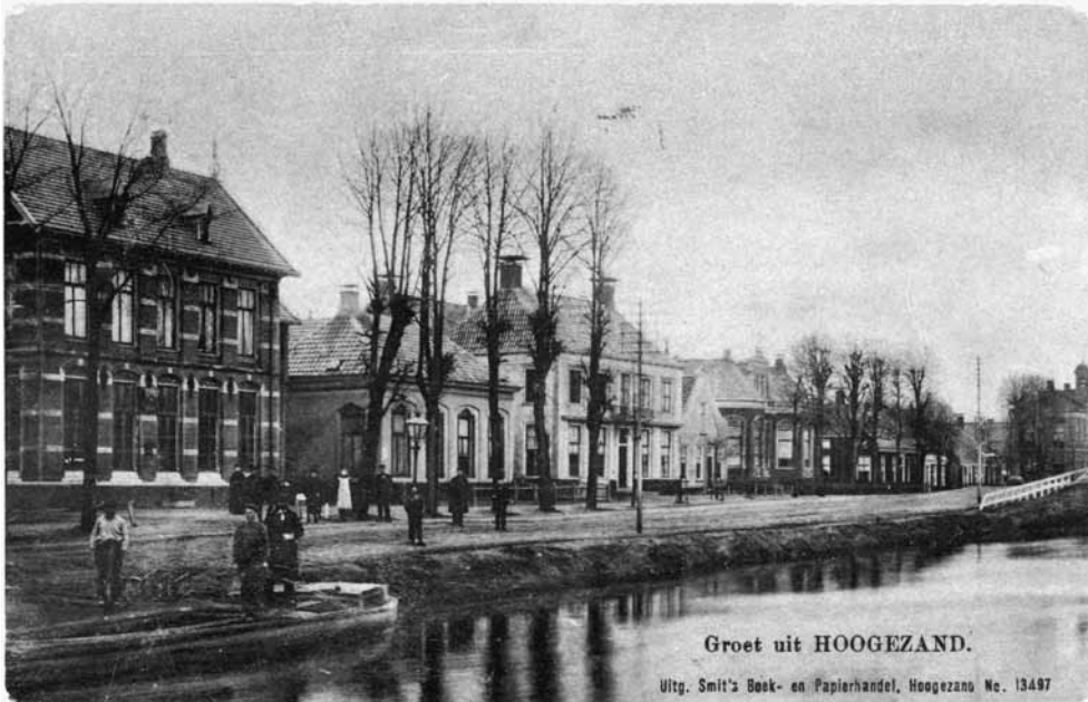
Aansichtkaart Hoogezand ca. 1900, gebouw derde van links is 'Het Regthuis'/hotel Faber
