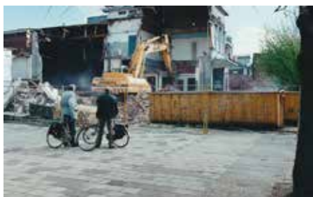
De sloop in volle gang
