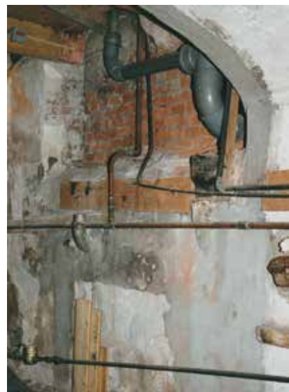
Het keukengedeelte in de kelder met de loden buis in de westelijke muur
