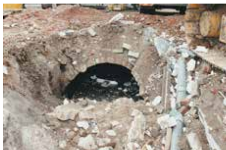
De bovenzijde van de waterkelder
