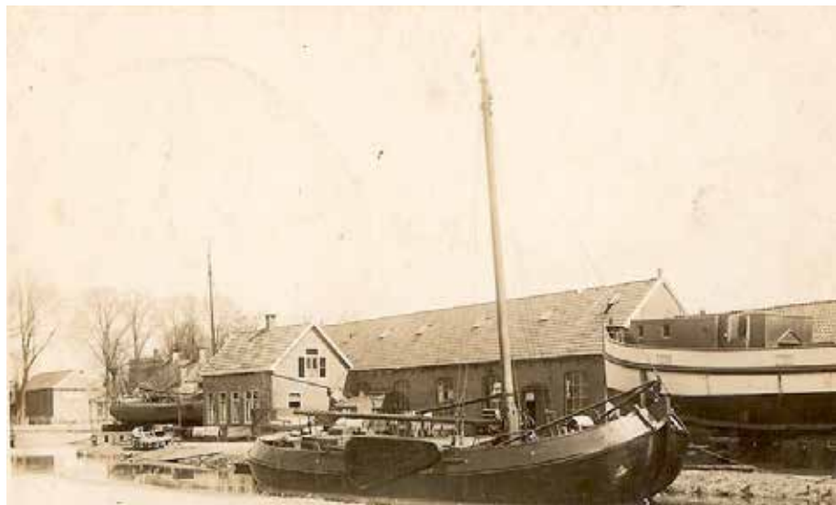
De werf van Menso Wolthuis begin jaren dertig. De dwarshelling is al aangelegd en een sleepboot is in aanbouw. De tegen de hellingschuur aangebouwde woning bouwde Menso in 1926 in verband met het vertrek van zijn broer Harm.
