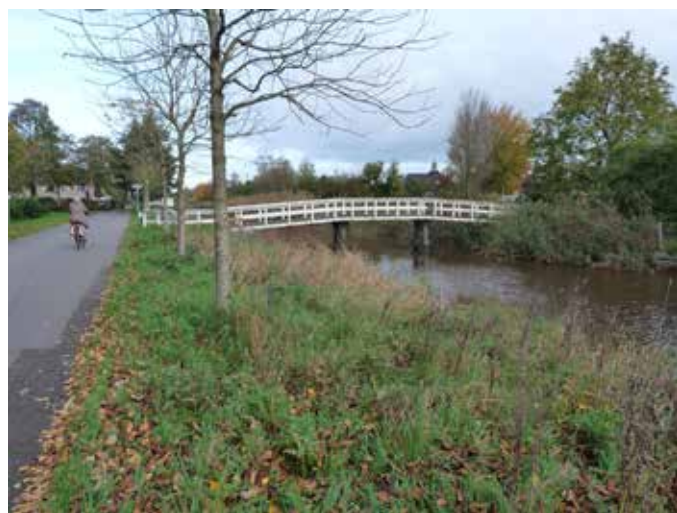
- 6 Loop- en fietsbrug ter hoogte van het Drevenbos
