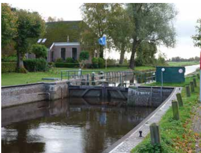
-11 Kielster Verloot, zuidelijke sluisdeur, t. h. v. Sluisweg 46/48
