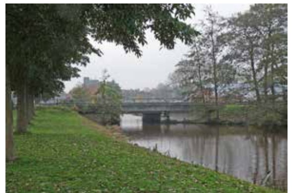
2 Spoorbrug spoorlijn Groningen - Nieuwes chans
